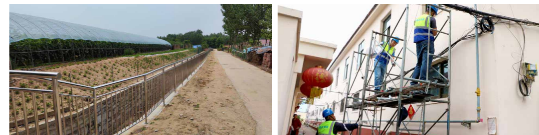
前立柱村新建好的排水沟
